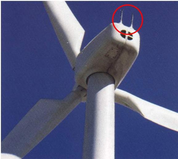
Cette éolienne produisant de l'électricité doit être le plus efficace possible. On utilise donc une méthode à fil chaud pour déterminer le sens optimal du vent et augmenter ainsi son rendement.
